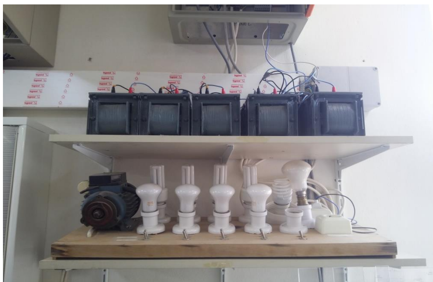
Εικόνα 4.4 Ελεγχόμενα φορτία στο εργαστήριο Συστημάτων Ηλεκτρικής Ενέργειας
